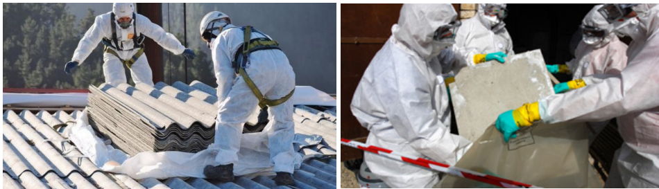
Figuras/Imagens 28 – Encapsulamento de materiais contendo asbestos sendo removidos com plástico
