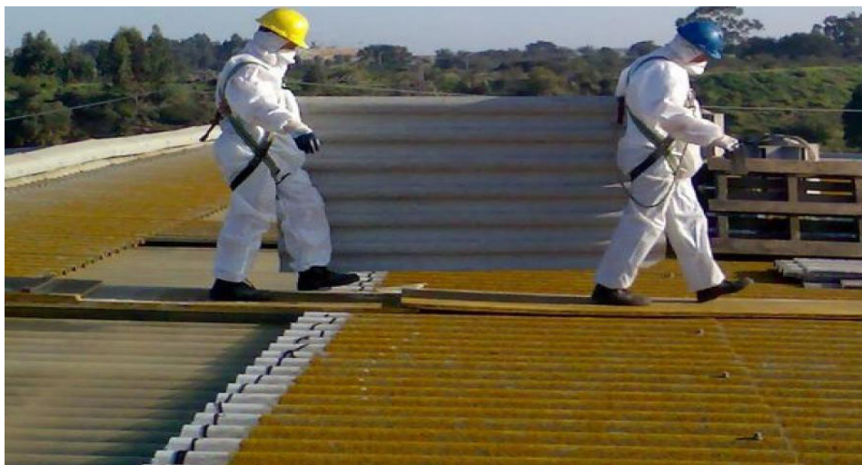
Figura/Imagem 1 – Remoção de fibrocimento com asbestos
