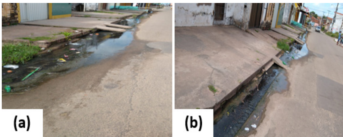
Figura 4 – Esgoto nas ruas Fonte: Dos autores (2019)
