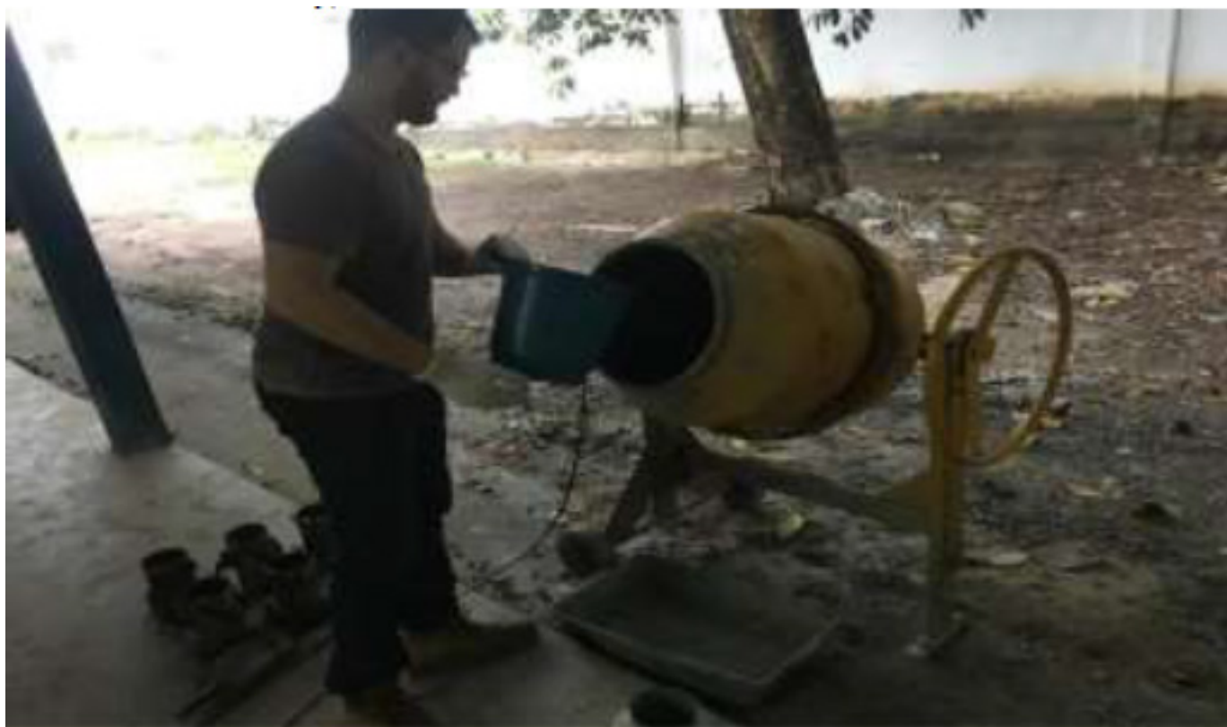
Foto 6 – Preparação do concreto (Fonte: acervo do autor )
