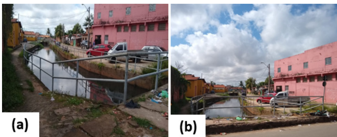
Figura 5 – Canal do Rio das Bicas Fonte: Dos autores (2019)
