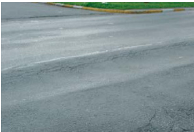
Figura 13 – Afundamento plástico Fonte: Bernucci et al. (2008, p. 419)
