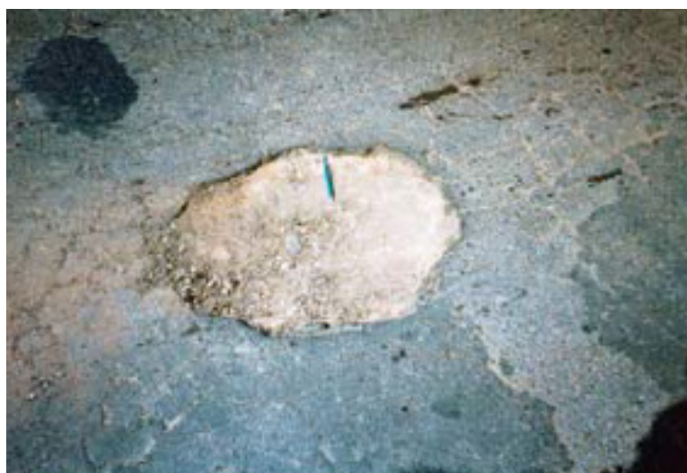
Figura 19 – Panela ou buraco Fonte: Bernucci et al. (2008, p. 422)
