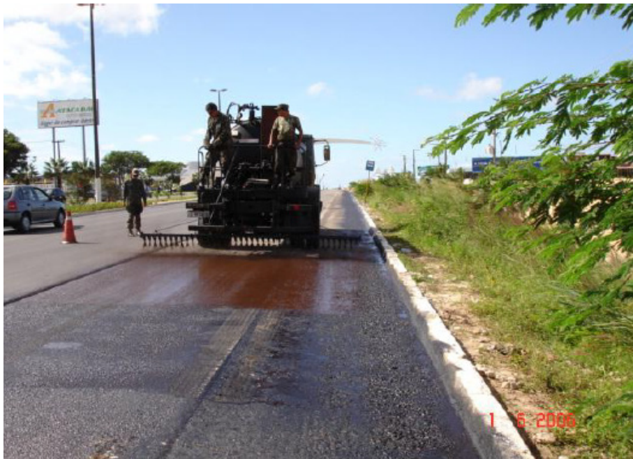
Figura 5– Barra espargidora de distribuição de asfaltos para AAUQ Fonte: BEC (2015, p. 03)
