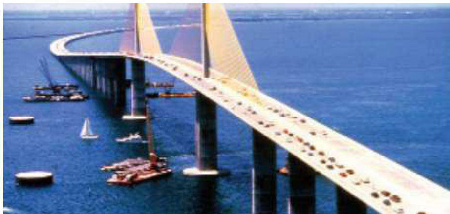
Figura 4: Ponte Sunshine Skyway onde foi usado concreto com cinza volante em muitas das etapas da construção
