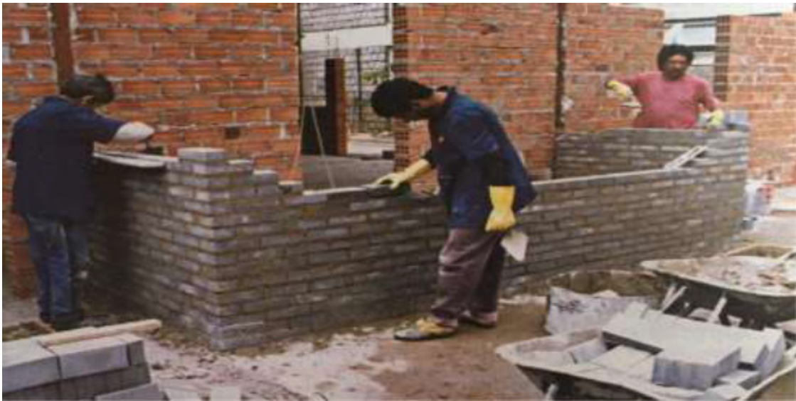
Figura 10 – Construção de alvenaria utilizando argamassa e tijolos com cinzas. (Fonte: Repositório CIEN-TEC)
