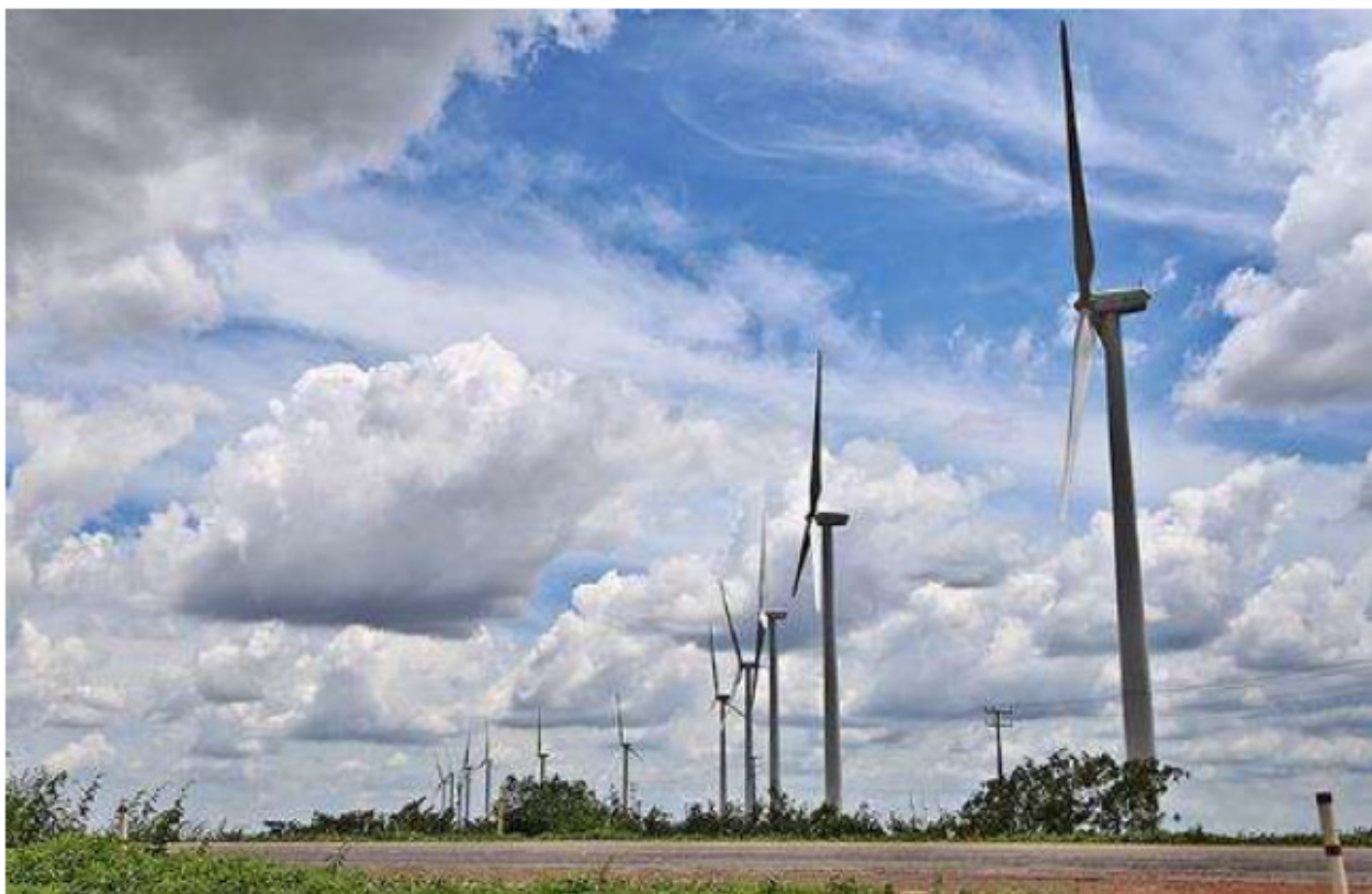
Figura 3 – Complexo eólico chapada do Piauí. (Fonte: Repositório da Queiroz Galvão Energia)
