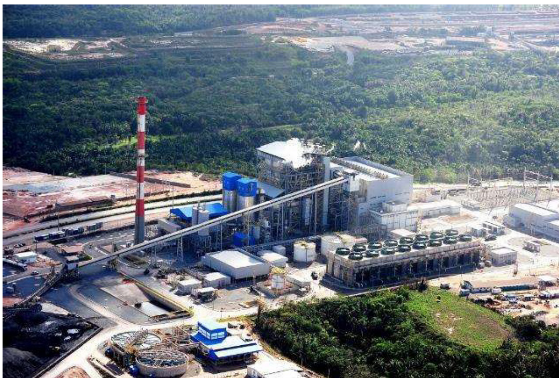
Figura 6 – Usina termelétrica ENEVA em São Luís. (Fonte: Repositório ENEVA – Itaqui)
