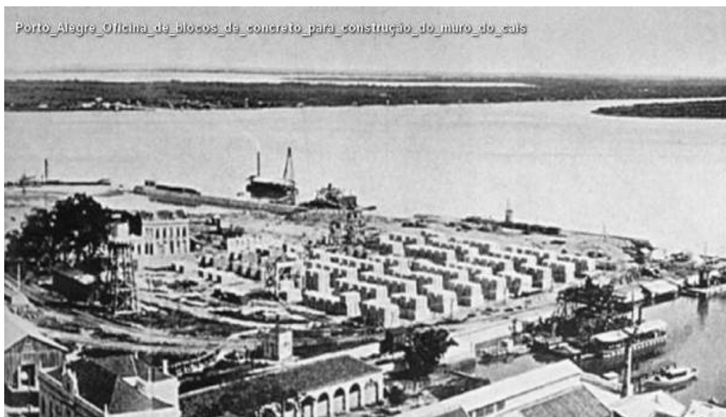
Figura 19 - Oficina de blocos de concreto para construção do muro do cais Fonte: www.flickr.com
