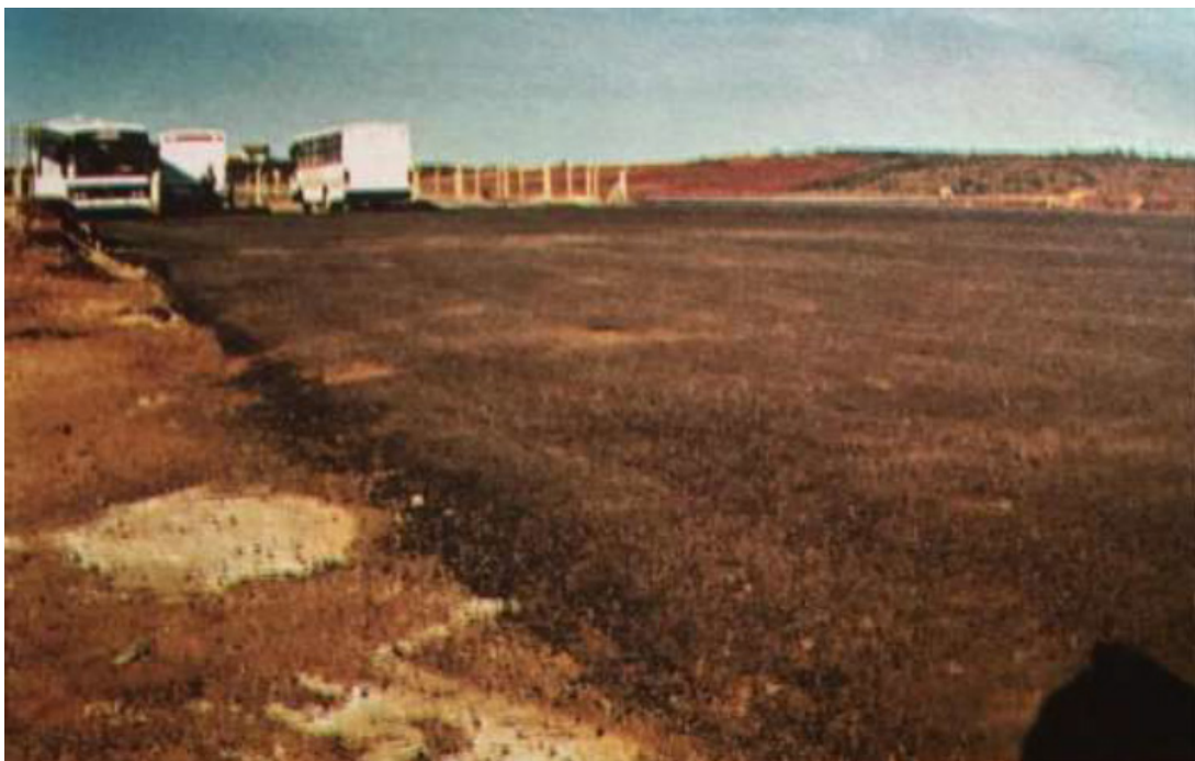
Figura 8 – Pátio de estacionamento com base de cinzas no município de Candiota – RS. (Fonte: Repositório CIENTEC)
