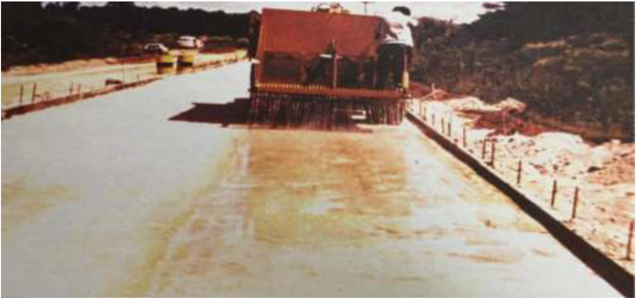
Figura 7 – Base sendo construída no trecho de acesso ao porto de Santa Clara – RS. (Fonte: Repositório CIENTEC)
