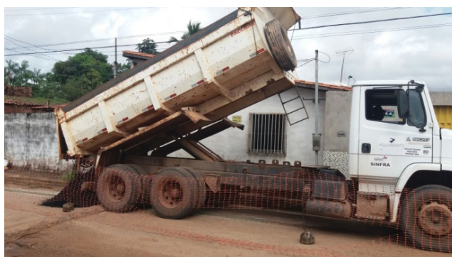
Figura 5 – Descarregamento do CBUQ Fonte: Elaboração dos autores
