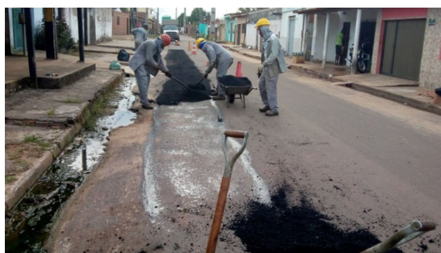
Figura 6 – Distribuição e espalhamento da massa Fonte: Elaboração dos autores
