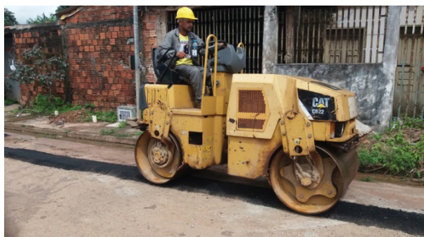
Figura 7 – Compactação e Acabamento Fonte: Elaboração dos autores
